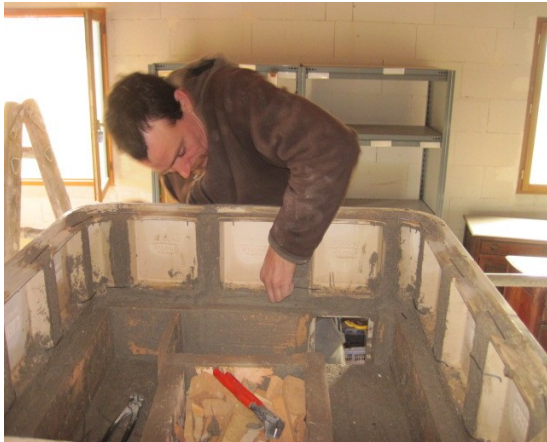
Construction traditionnelle de poêle en faïence
