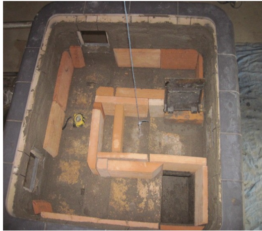
Construction traditionnelle de poêle en faïence
